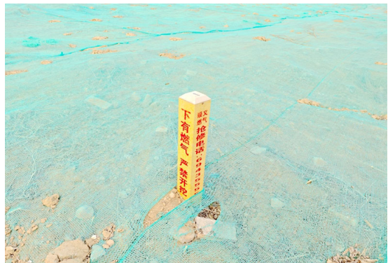
项目内燃气桩
