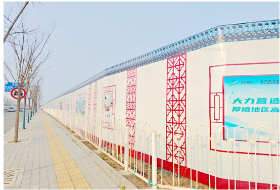
项目西侧围挡
