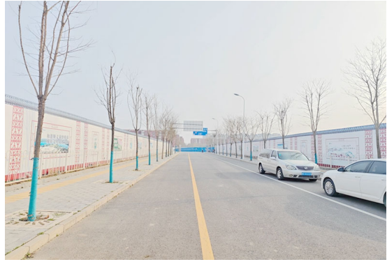
项目西侧现状道路
