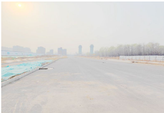
项目北侧现状道路
