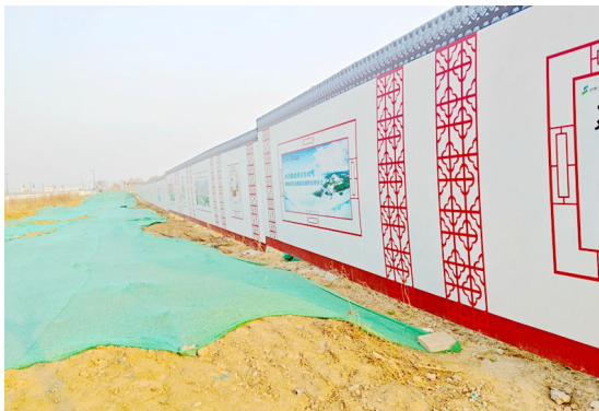
项目北侧围挡
